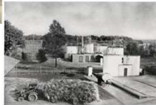
Im Hintergrund: 4 Feuertürme, 2 BiHu-Dung-Silos, 1 Gasschleifer, Heizerwerkraum, Maschinenhaus mit Kompressionsanlage, dann Gastankstelle, links daneben 2 Drehbänke für Strichholzer Im Vordergrund: 1 Leuchte-Holzhälter an der Stirnwand der früheren Kalksteinplatte, daneben Spezialverleijührung für BiHu-Dung und 2 BiHuger-Gas-Schlepper
