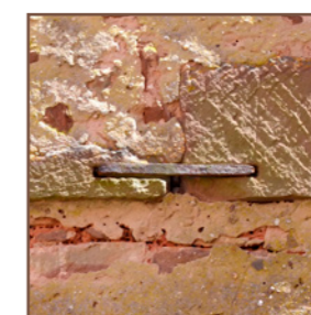
Bois de charpente et maçonnerie renforcés par des pièces métalliques (tirants*).
