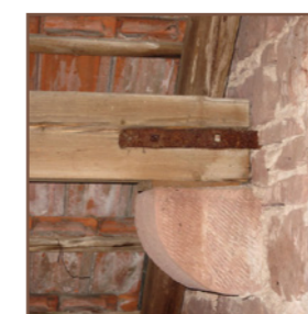
Bois de charpente et maçonnerie renforcés par des pièces métalliques (tirants*).
