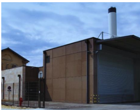
Chaufferie biomasse de Langres
