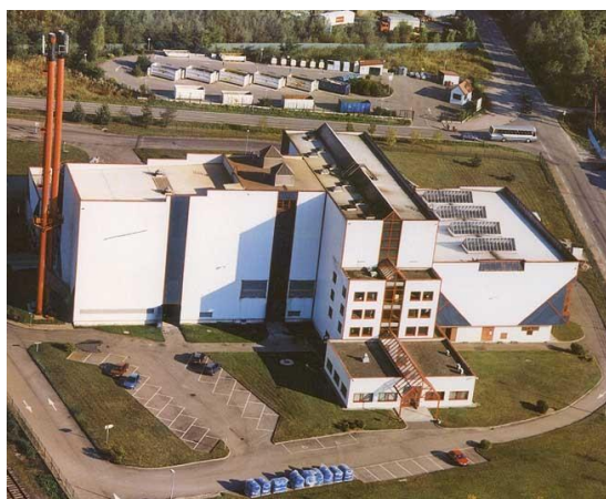
Vue aérienne de l'UVE de Schweighouse Crédit photo : SMITOM de Haguenau-Saverne
