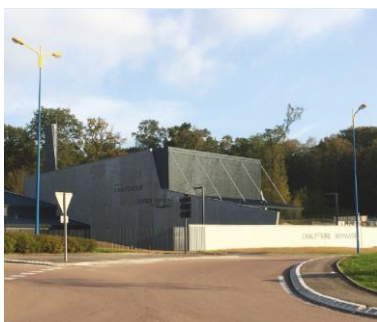
Chaufferie bois de Saint-Dizier Crédit photo : Ville de Saint-Dizier
