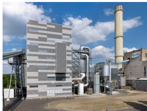
Unité biomasse du site de Metz-Chambière Crédit photo : Rémi Villaggi
