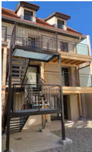
Après - Façade arrière
