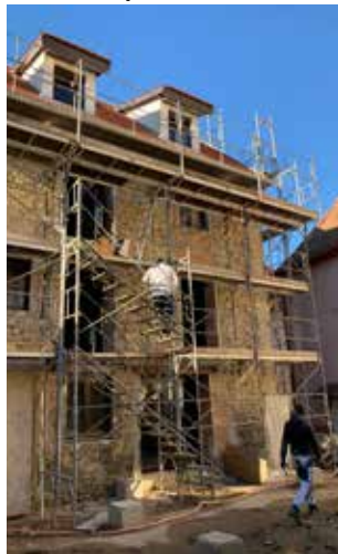
Avant - Façade arrière
