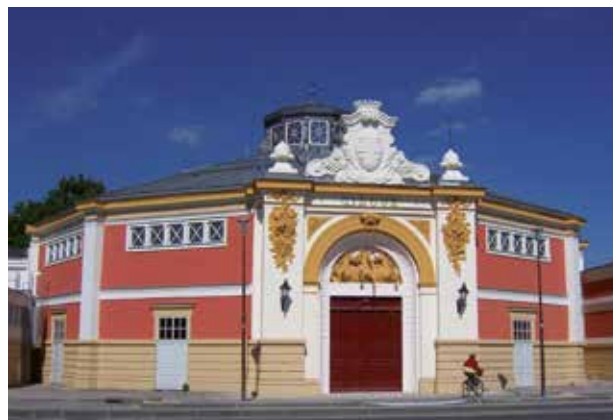
École des arts du cirque à Chalons : 316 kW chaud sur nappe
