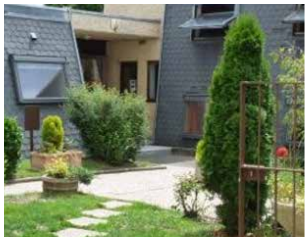
Maison d'Enfants à Caractère Social à Vilcey-sur-Trey (54) – 50 sondes de 99 m de profondeur - 300 kW chaud et 232 kW froid
