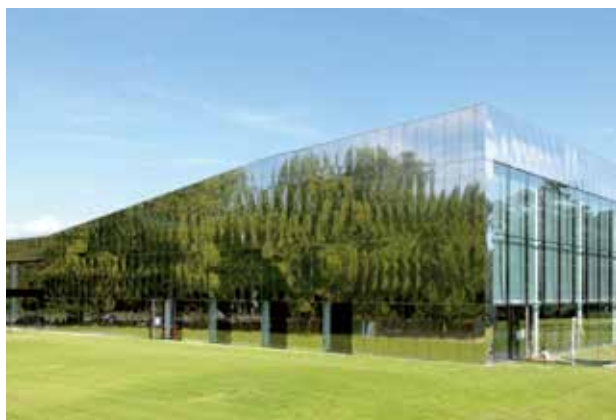
Piscine de Kibitzenau Strasbourg - sur nappe - 524 kW chaud, 427 kW froid
