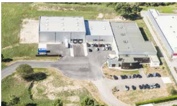
Laboratoire industriel SALVECO à Saint-Dié-des-Vosges (88) - 12 sondes de 100 m sous le bâtiment – 52 kW chaud pour Eau Chaude Sanitaire (ECS)
